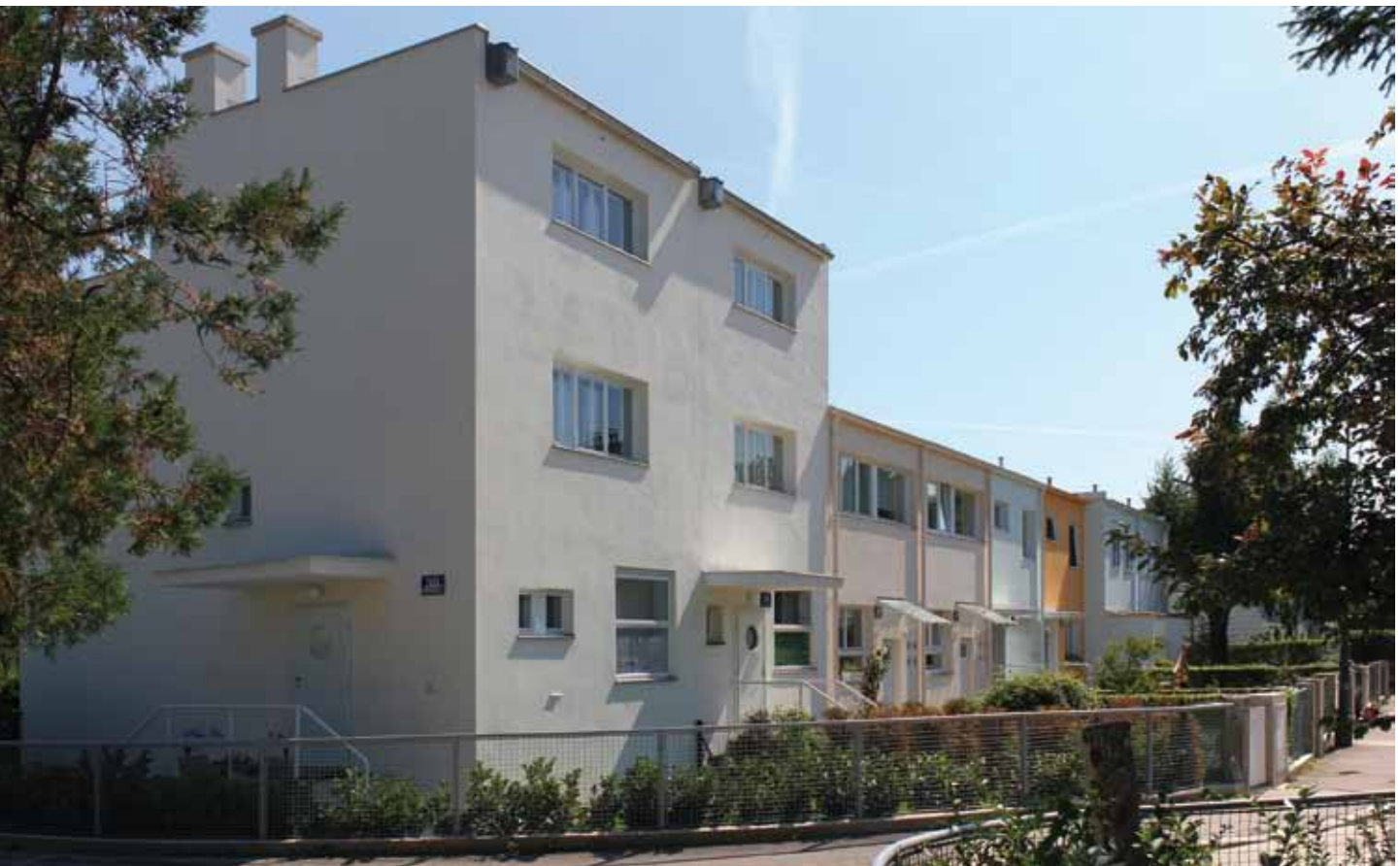
oben: saniertes Haus von Karl A. Bieber / Otto Niedermoser, Woinovichgasse 30
