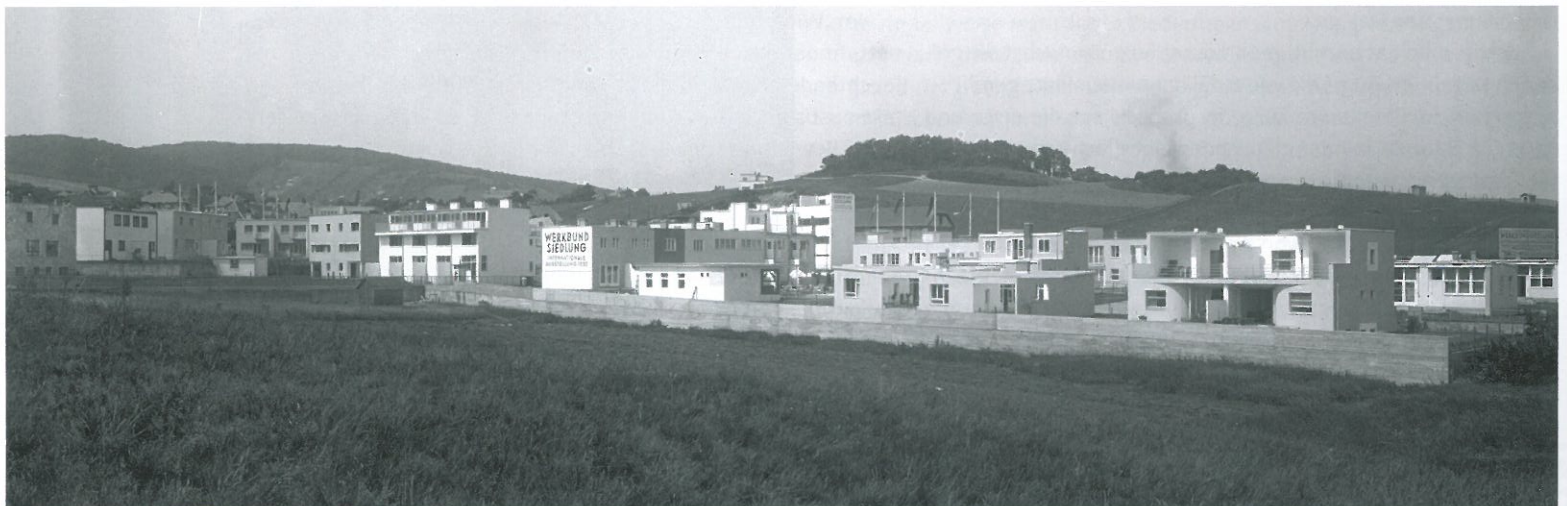
Blick auf die Werkbundsiedlung von Süden, 1932 (© Wien Museum/Foto: Martin Gerlach)
