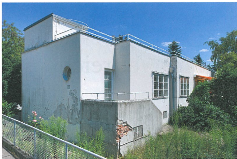
Haus Hoffmann Gartenseite vor- und nach der Sanierung (Foto: © Adsy Bernart)
