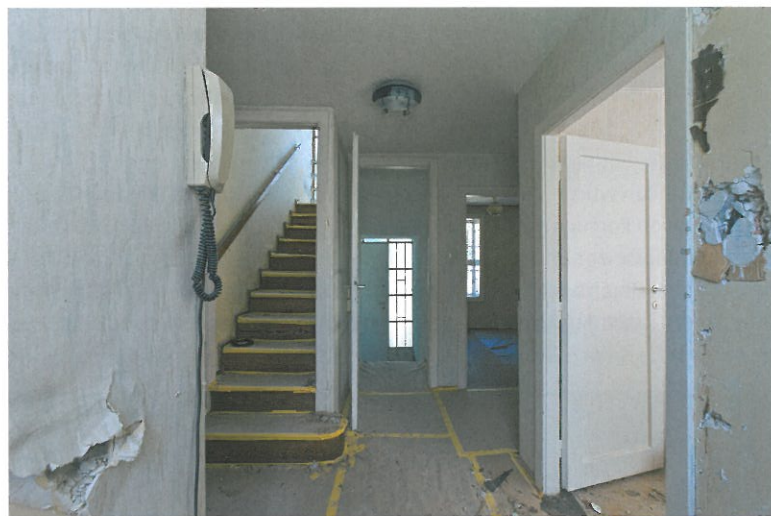
Haus Hoffmann Foyer vor- und nach der Sanierung (Foto: © Adsy Bernart)
