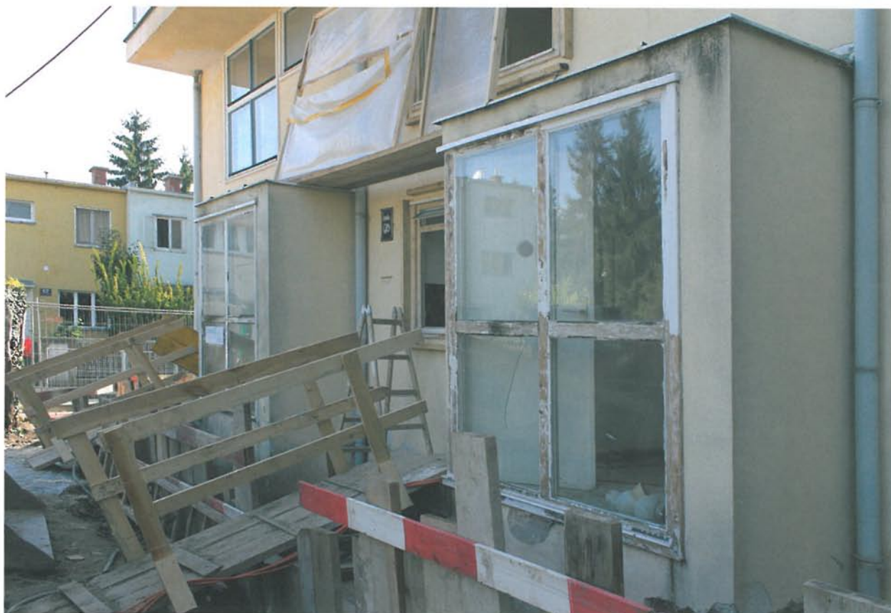
Abb. 283 Woinovichgasse 18 und 20 von Gerrit Rietveld während der Sanierung. Foto: Martin Praschl, 2011
